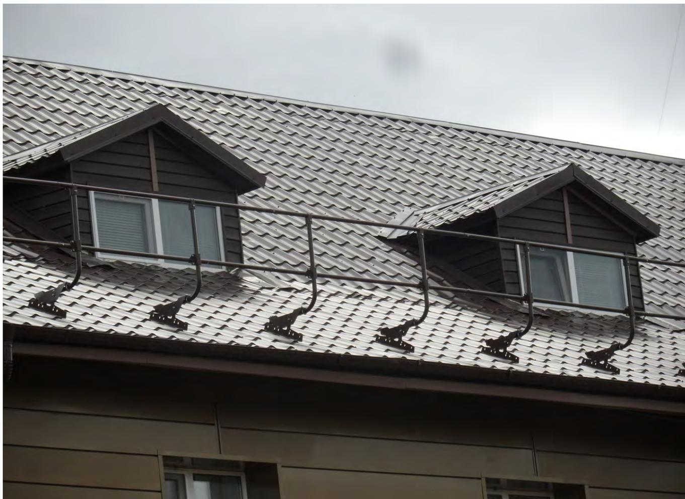
Ограждение кровли перилами предотвратит падение человека во время ремонтных работ на крыше, установки антенны, при чистке вентиляционных или каминных труб, а в зимне-весенние месяцы задержит лавинообразный сход снега или льда. К тому же обезопасит людей и имущество от случайных падений предметов при проведении кровельных работ. Ограждение для кровли представляет собой стальные решетки, которые бывают и в виде балясин или парапетов, возвышающихся над кровлей.
