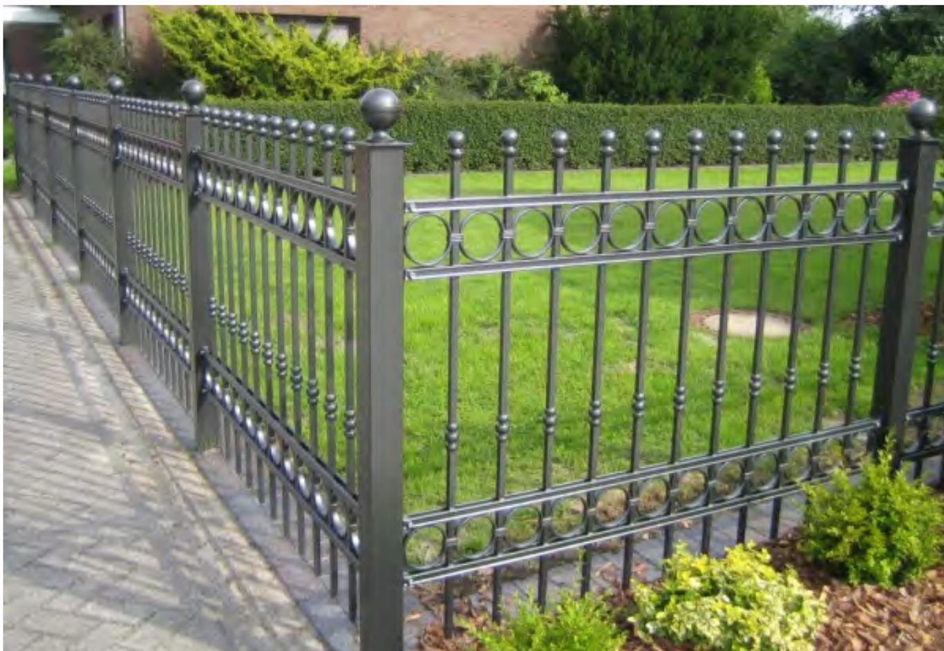
Основная часть конструкции ковано-сварных заборов выполнена из сваренных профилированных труб, украшенных литыми пиками, и цельнометаллических полос — обладают сразу несколькими сильными сторонами:
